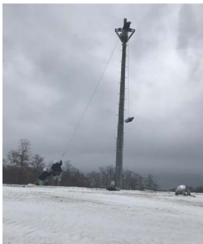
斜面では高所作業車を使えない。滑車で引き上げる。
